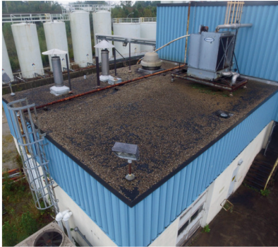
1. Superficie original de techo BUR con grava
