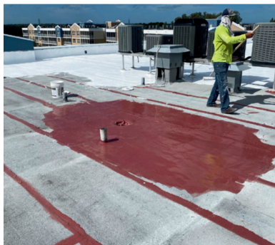
AUTONIVELANTE (NO REQUERIDO)
