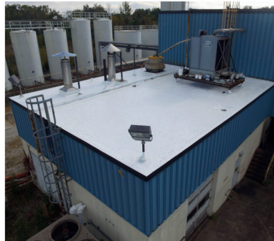
5. Aplicación del recubrimiento de silicón HS 3200 para techos
