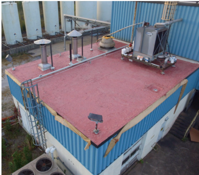
4. Aplicación del recubrimiento nivelador SL 800
