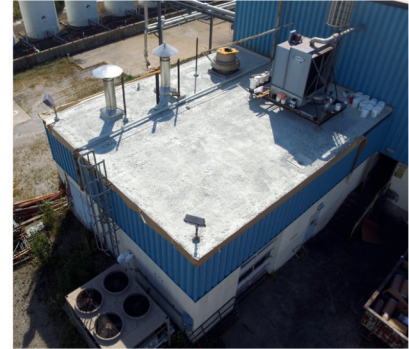
3. Aplicación de primario P-160 Bleed Block (opcional)
